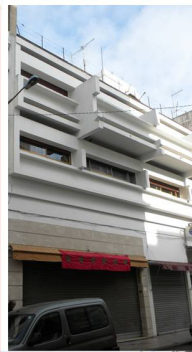
Eléments de décoration moderne, en béton et enduit blanc, marquant l'horizontalité de la façade.
