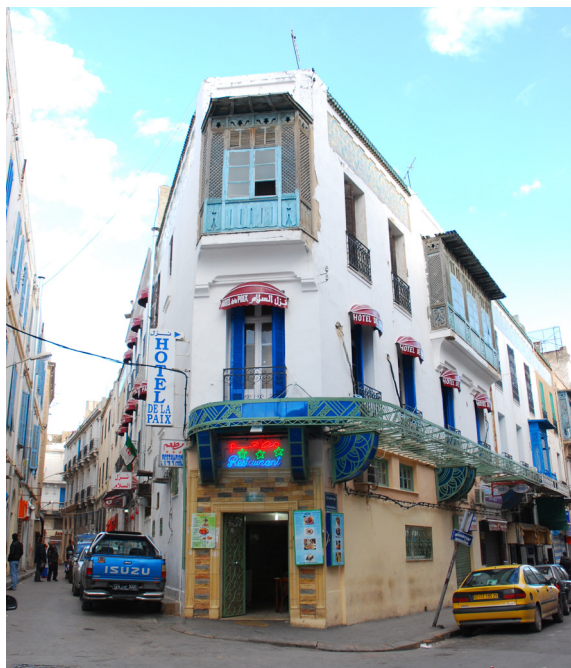
Fig. 2. Grand hôtel de France, Tunis, Architecte Jean-Emile Resplandy, début du XX ème siècle. Photographie de Michel Mus.
