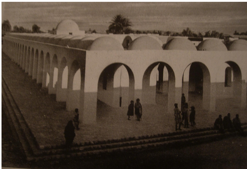
Fig. 5. Marché couvert de Sidi Bou Zid (Tunisie), Bernard Zehrfuss, Jean Drieu la Rochelle et Jason Kyriacopoulos, 1946. Source : L'architecture d'aujourd'hui , n. 20, 1948, spécial Tunisie, p. 78.
