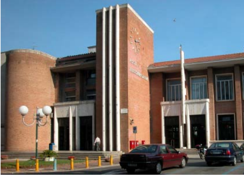
Fig. 9. Latina, le bureau de la Poste, Angelo Mazzoni. Photographie de Romeo Carabelli – 2004.
