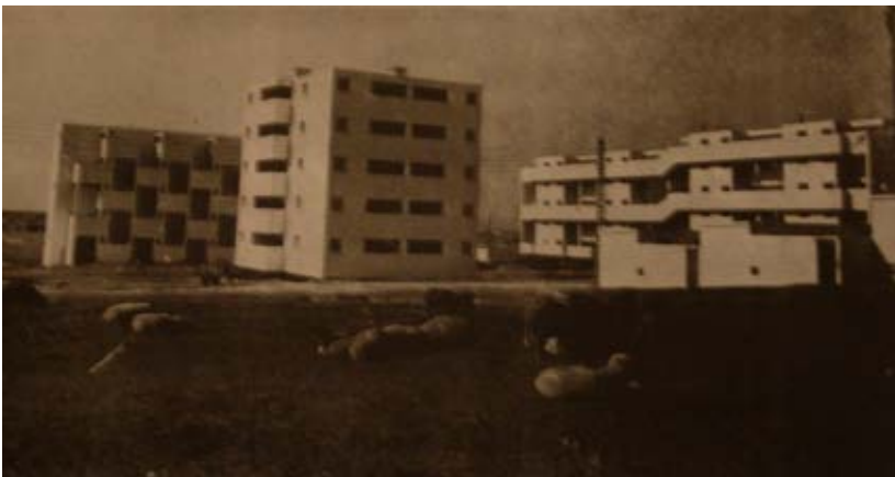
Fig. 8. Immeubles dans le quartier des Carrières centrales, Casablanca. A gauche ; l'immeuble Nids d'abeille et à droite l'immeuble Sémiramis, Architecte : Atbat-Afrique. Source : L'Architecture d'Aujourd'hui , n. 60, spécial Afrique du Nord, juin 1955, p. 39.
