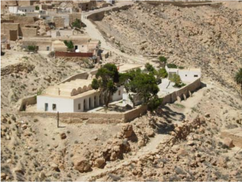
Fig. 7. Ecole-type, architectes : Zehrfuss, Dricu La Rochelle et Kyriacopolous, Toujane (Tunisie). Photographie de Charlotte Jelidi – juin 2010.
