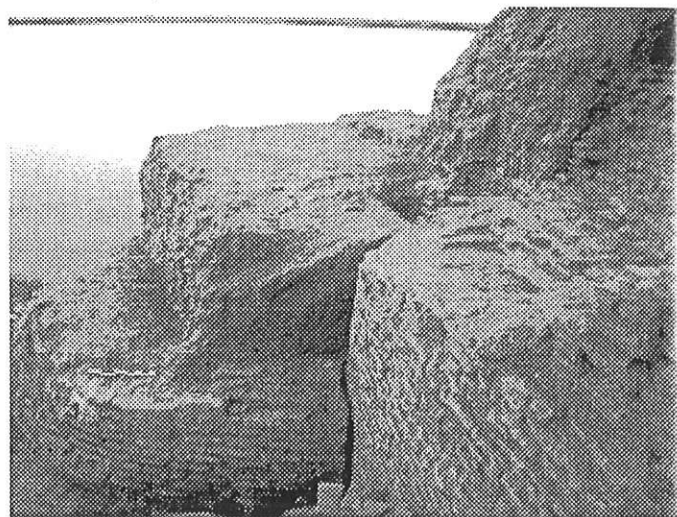
4 - Angle sud-est. Le contact entre le mur D et le bastion R après fouille partielle de R et dégagement de la face de D. Vue vers le sud.
