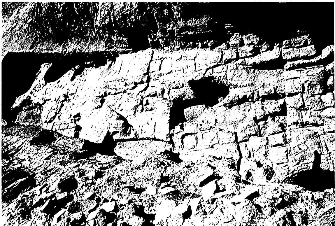
Fig. 16: Termez. chantier D. Détail des différentes maçonneries de briques crues. Vue vers l'ouest.
