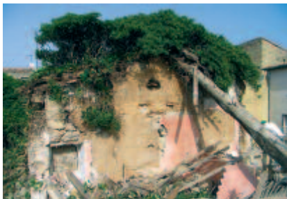
Figure 2. Pan de mur en pisé. Montagnac, France, XIV e s. (T. Lochard).
