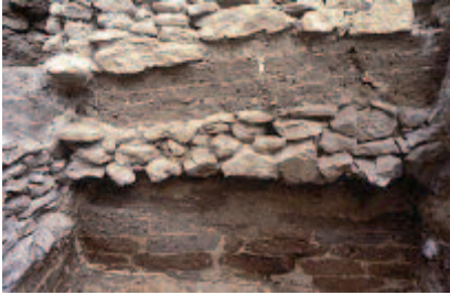
Figure 3. Murs d'adobe superposés. Martigues, France, IV e s. av. n. à. (J. Chausserie-Laprée).
