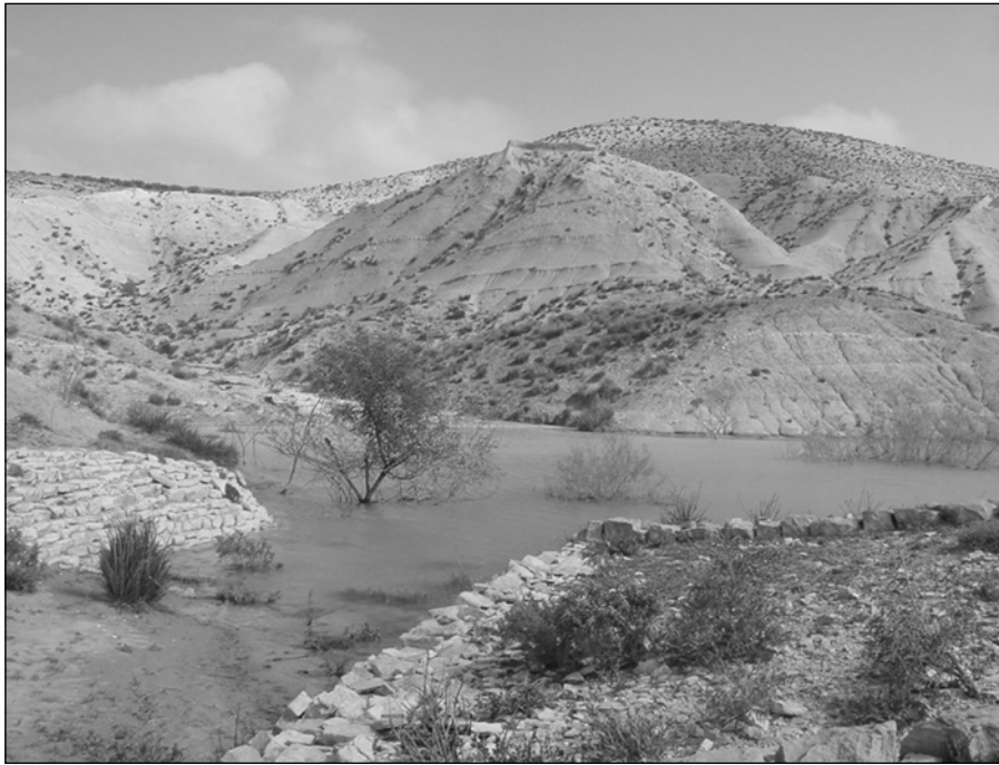
Figure 4. Sédimentation d'un petit lac collinaire causée principalement par le ravinement d'un glacis encroûté sur marnes situé en amont (El Hnach, juillet 2001, cliché E. Temple-Boyer).
