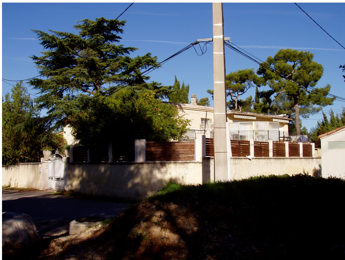
Document 11: Maison sur l'emplacement de la construction de 1819 et 1824. Photo du 11 octobre 2009. © 2009 Gilles OLIVE.
