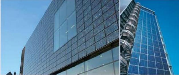
Bardage solaire en modules au silicium multicristallin (façade bleue)
