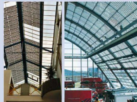
Verrières photovoltaïques à modules semi-transparents au silicium cristallin
