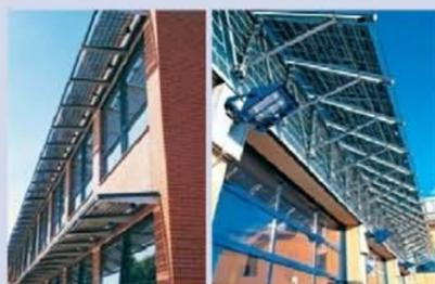
Brise-soleil à modules semi-transparentes au silicium monocristallin
