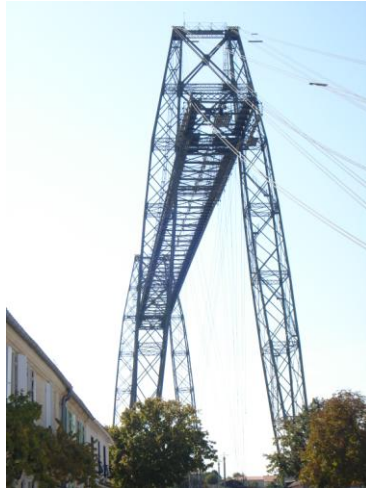
Une vue du pont à transbordeur de Rochefort - Photo P. Naegel - 2009
