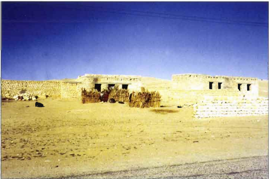
Habitations de bédouins sédentarisés à Dghoumes au Jérid. Hûsh au mur d'enceinte inachevé. Zriba-s pour les animaux placées devant la pièce d'habitation.
