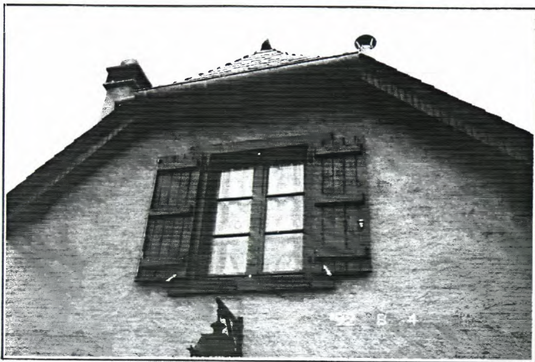
Marsous, une grange aménagée "2 e génération" : rebord en menuiserie, l'ouverture a été agrandie pour servir de fenêtre au grenier transformé en dortoir.
