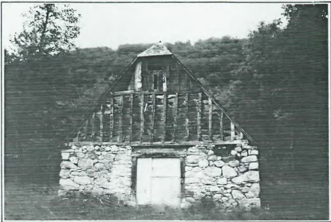
Marsous (Val d'Azun), une grange avec la toiture à coyau et le pignon en partie à clair-voie.
