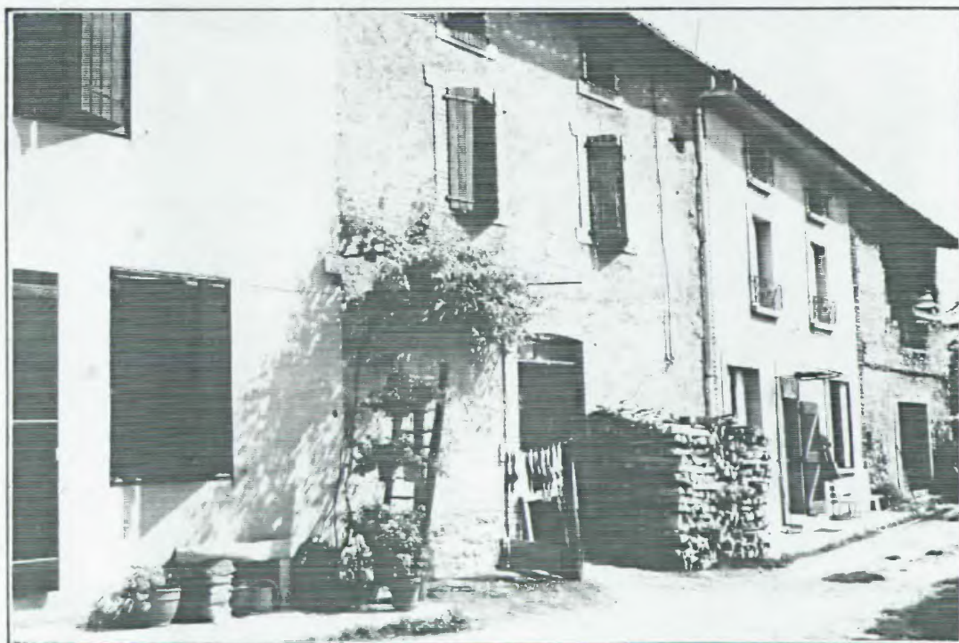
Montségur. Cinq maisons sont alignées le long d'un passage : au premier plan, une maison principale restaurée par une enseignante native du village revenue au pays après 20 ans d'absence. La maison avec la glycine est celle de sa mère, habitation rénovée il y a 20 ans. La maison suivante avec la marquise est celle de leur parente. Au fond une grange qui s'écroule.
