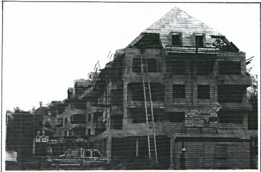
Appartement de "standing" en construction à Laguiole. Seront aussi des résidences secondaires pour les parents âgés. Prix : 9300F le m 2 , Aubrac aveyronnais, avril 1994.
