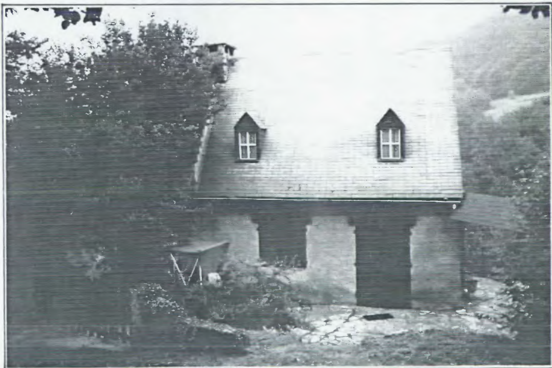
Lommé, restauration inspirée par le style du pays : "redents" conservés, petit portail couvert placé arbitrairement, dallage en travertin, combles aménagés et "capucines" remodelées.
