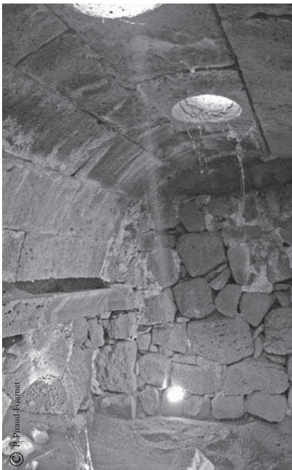
Fig. 20 Salle chauffée par hypocaustes des petits bains privés d'une maison de 'Imtan en Syrie du Sud (inédit). Photo P. Piraud-Fournet.
