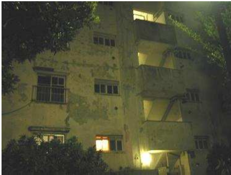
Tama : danchi dégradés et vacants (2006) (E. Ducom).
