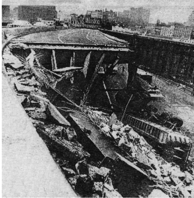
Effondrement d'une section de la West Side Highway
