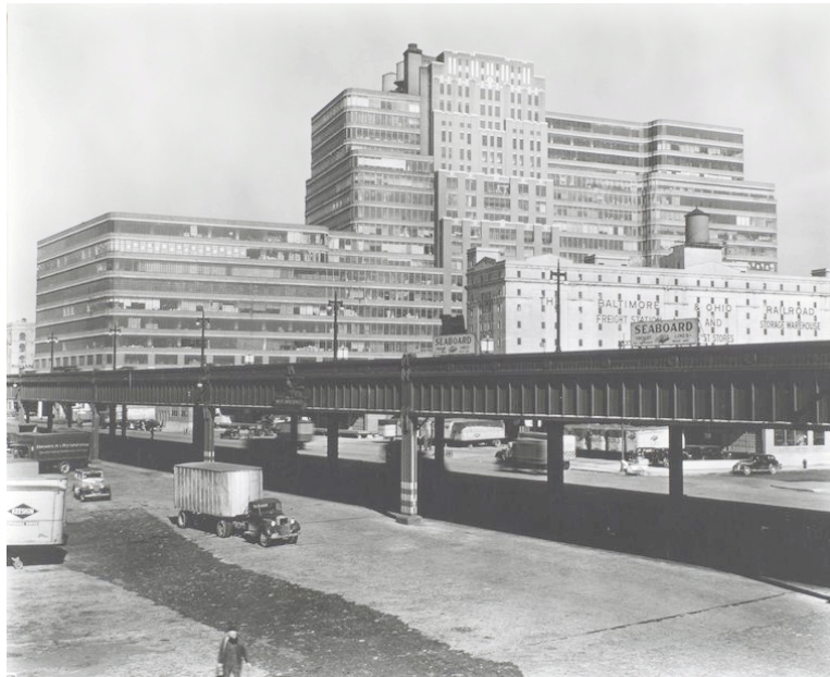
Section de la West Side Highway au niveau de la 26 th Street Ouest
