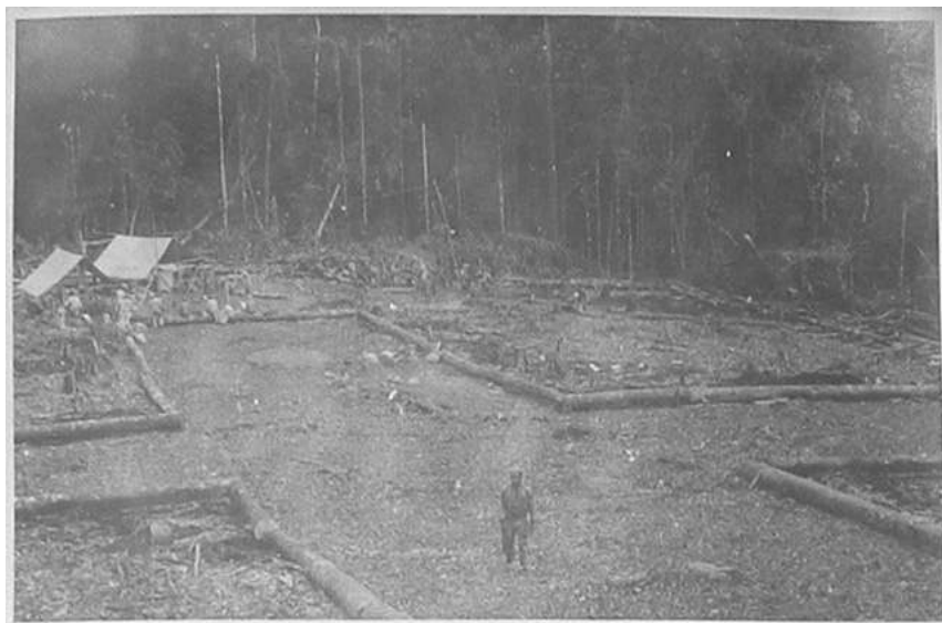
Photo 6 : construction d'un signal aérien en pleine forêt 54 .
