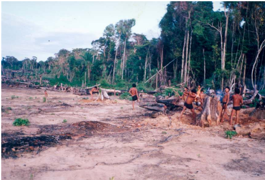
Photo 26 : construction de la piste Balawau, juillet 1992. 545
