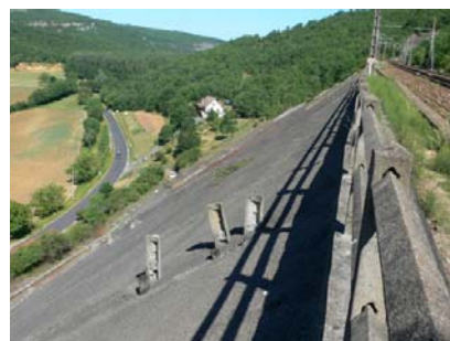
Abb. 10 : Sicht auf die Krone des Dammes (rechts die Bahnlinie)
