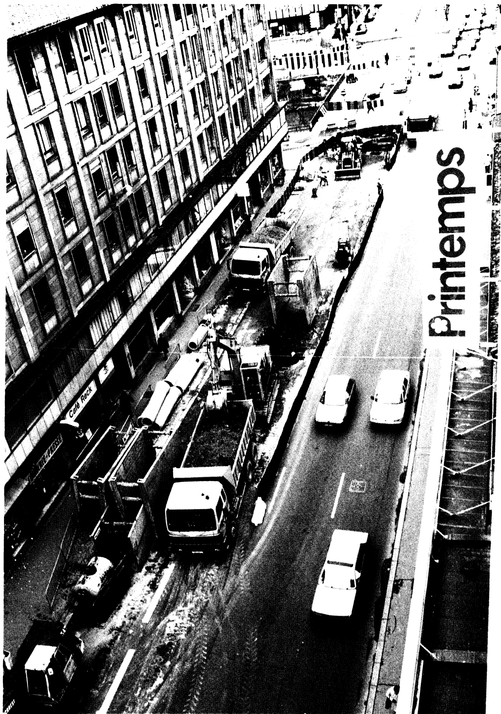
Rue du Noyer : vue d'ensemble des travaux de réseaux (Photo F. Schneikert).
