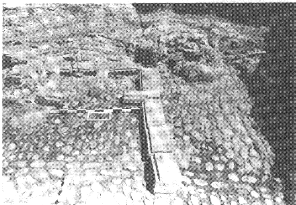
Une fenêtre du mur couché. L'arc de décharge en briques au dessus du linteau s'est disloqué en s'écrasant contre le mur du bâtiment nord.
