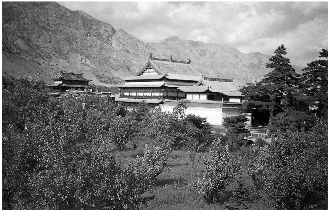
Fig. 1. Vue latérale du temple principal depuis l'ouest (© Isabelle Charleux)
