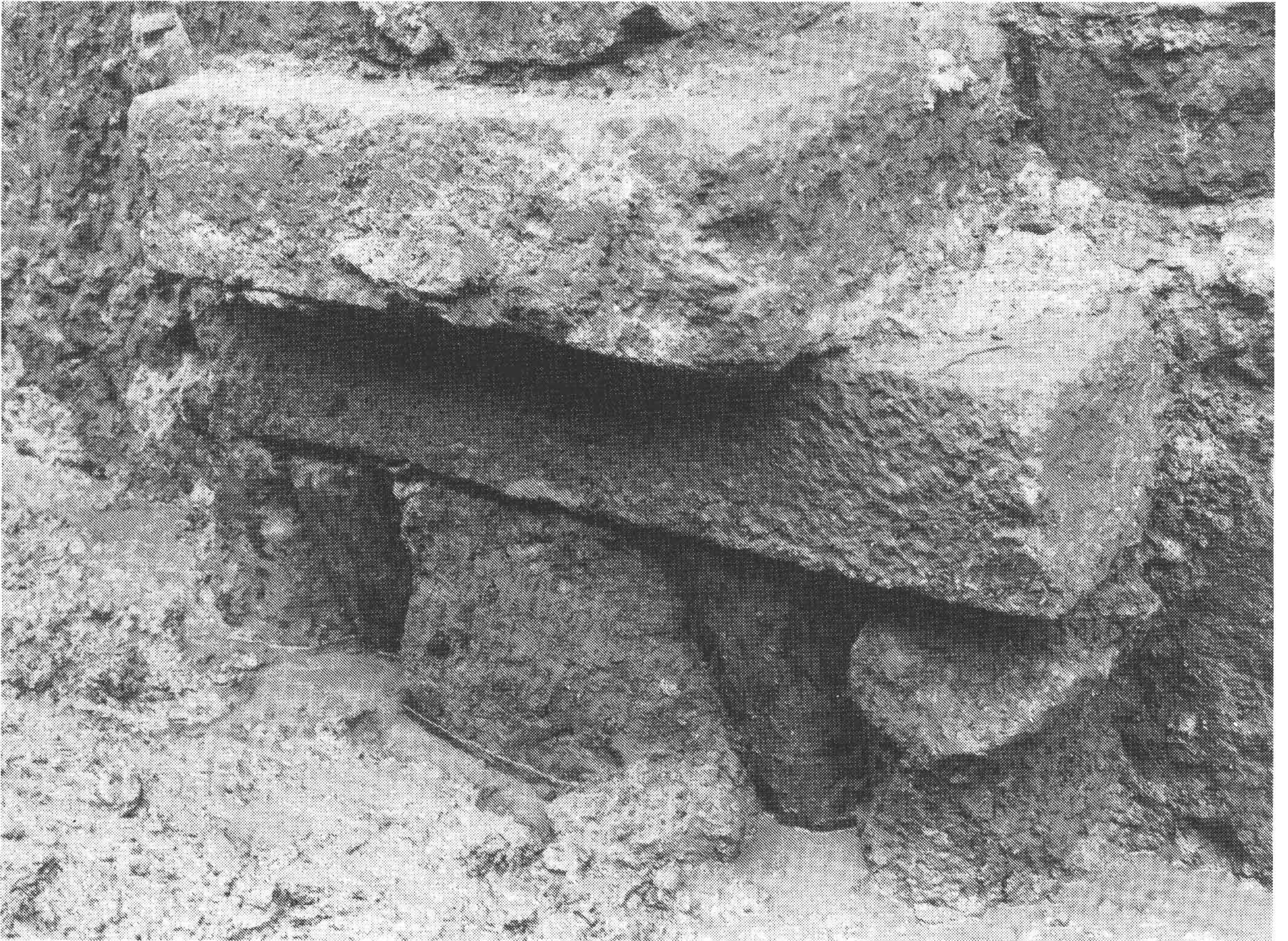
Fig. 5 Caserne Barbade, fouilles 1986. Base d'une pile du refend central avec deux pieux et semelle en pierres de taille.
