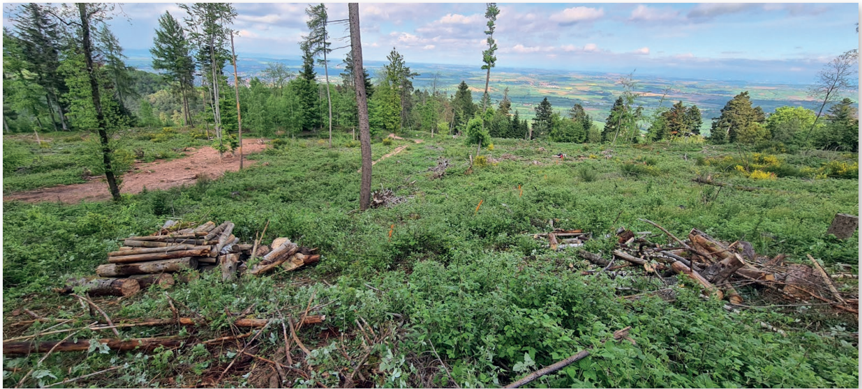
Figure 18 (ci-dessus) : Vue vers l'est de l'emplacement du sondage 7 après un premier nettoyage du versant (débitage des troncs, etc.). Les piquets orange marquent l'emprise des tranchées. On distingue le sondage 5 rebouché, à gauche (Cliché : S. Gentner)
