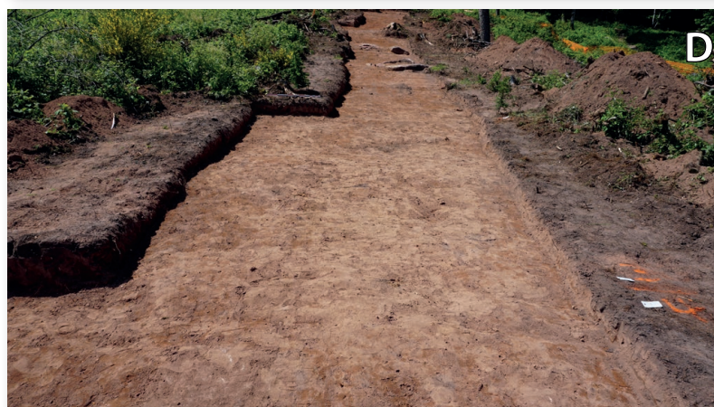
Annexe 1 : Vues des tranchées 1 (A-B) et 3 (C-D) du sondage 7 après le décapage (Clichés : S. Gentner)
