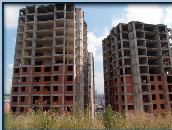
Photo ci-dessus : En périphérie ouest de la municipalité du grand Istanbul, Esenyurt est l'un des arrondissements les plus peuplés, avec près d'un million d'habitants. Ici, en mai 2023, un chantier de construction à l'arrêt montre le ralentissement économique dans ce secteur pourtant très dynamique. (© Yoann Morvan, mai 2023)
