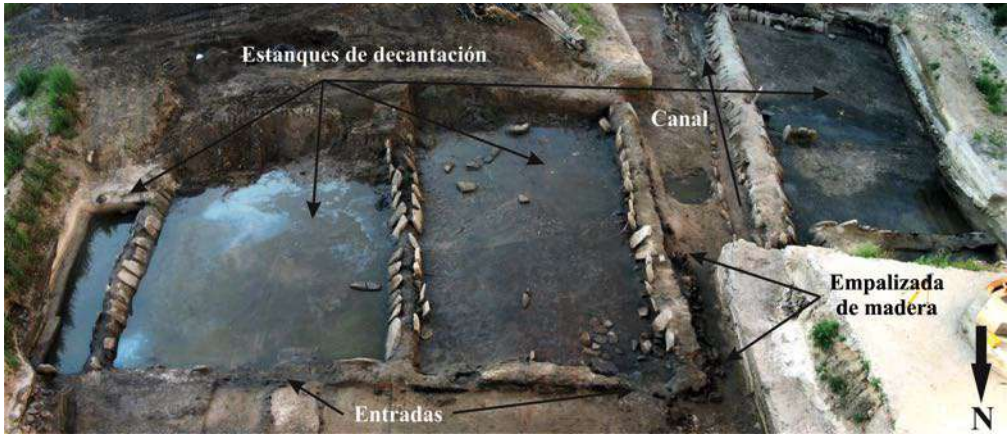
9 Vista general desde el norte de los decantadores.
