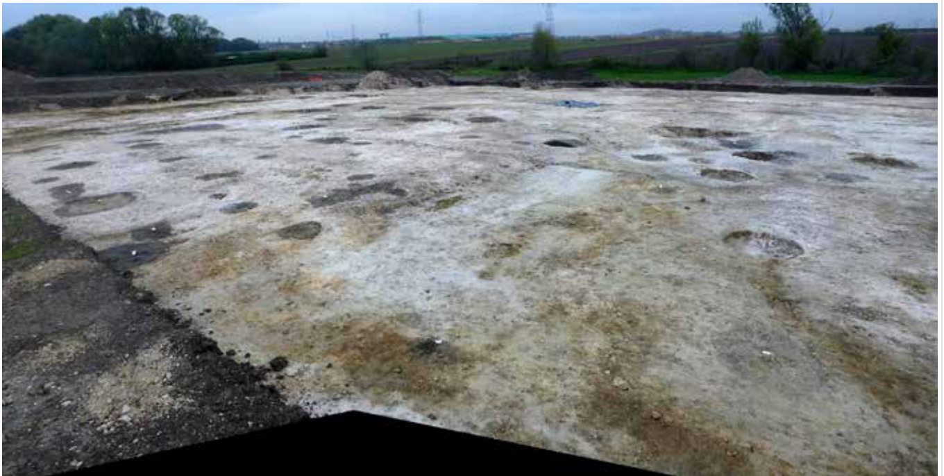
▲ Partie Nord de l'emprise, vue panoramique depuis le Nord-Ouest à l'issue de décapage
