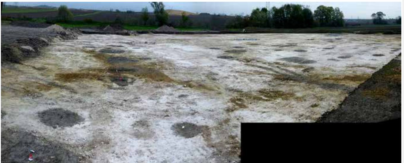
▼ Partie Nord de l'emprise, vue panoramique depuis le Sud à l'issue de décapage
