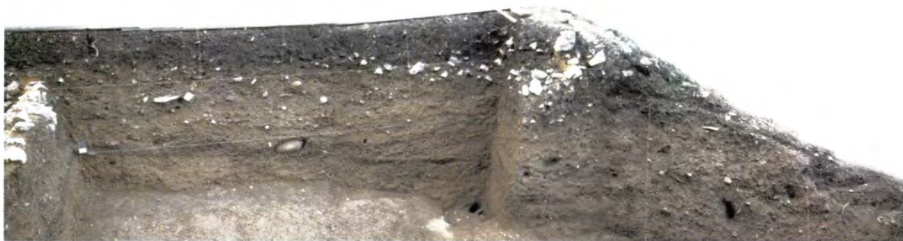
a Coupe ouest-est dans le bastion nord (cf. ill. 23). À gauche, on aperçoit le mur est de la cave.
