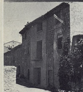
enduit ciment sur limousinerie jusque là non enduite (les linteaux béton sont cachés) I.I.A.4.
