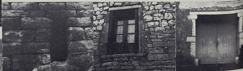
solide harpage original de la maçonnerie des ouvertures dans le mur ▼
