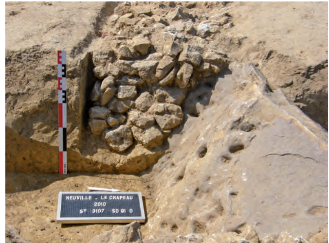
Fig. 78. Neuville-sur-Sarthe, Le Chapeau, Zone 3/État 6, la Structure 11 (SD 91), coupe sud-nord dans ST 3107, montrant la tranchee de fondation s'appuyant en partie sur un bloc de grès de Sargé en place dans le terrain naturel, vue prise vers l'ouest, mire de 0,5 m (cliché N. Tourancheau).
