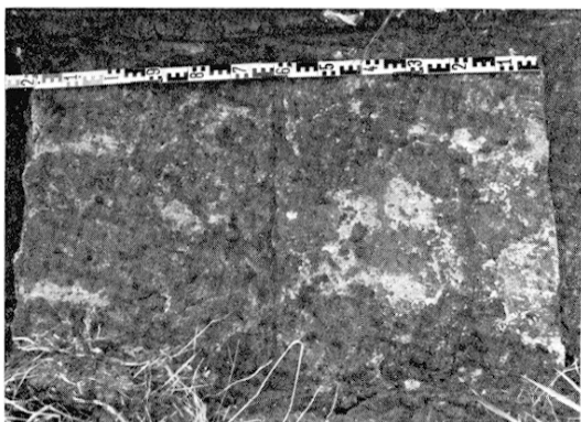
3 Mur de soutènement o. de la terrasse des thermes.
