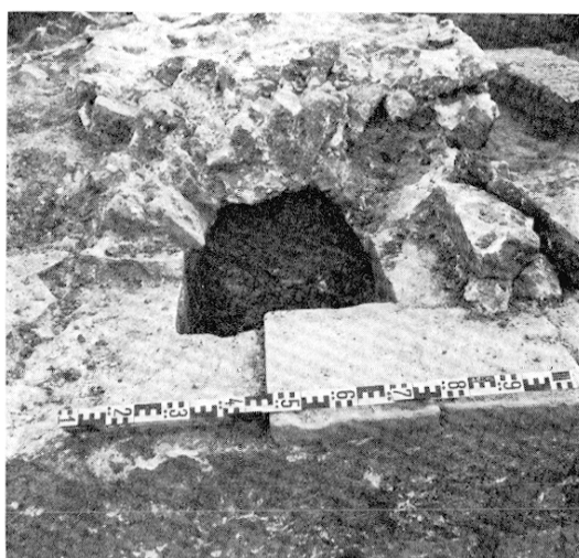
7 Regard du conduit voûté.
