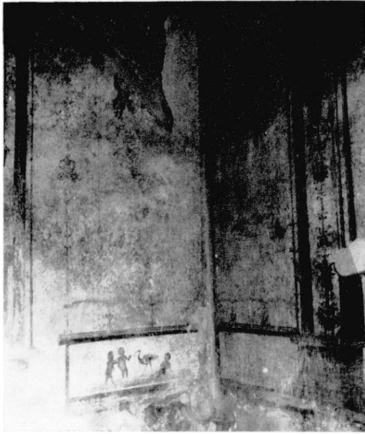
15 Pompéi, maison des Noces d'argent, pièce q, mur de droite.
