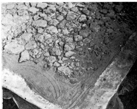
14 Peinture murale de Mercin-et-Vaux. Une mince couche de mortier synthétique est coulée pour protéger les bords des fragments de peinture. En bas à droite , on voit les deux toiles, la gaze et la toile collées sur la peinture, dont la face se trouve contre terre.
