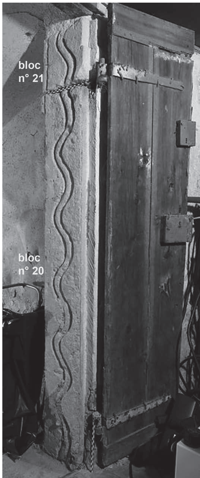
Fig. 13 – Blocs nos 20 et 21 (cliché : Ph. Groscaux, CCJ).
