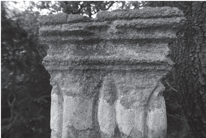
Fig. 17 – Bloc n° 10 (cliché : L. Damelet, CCJ).
