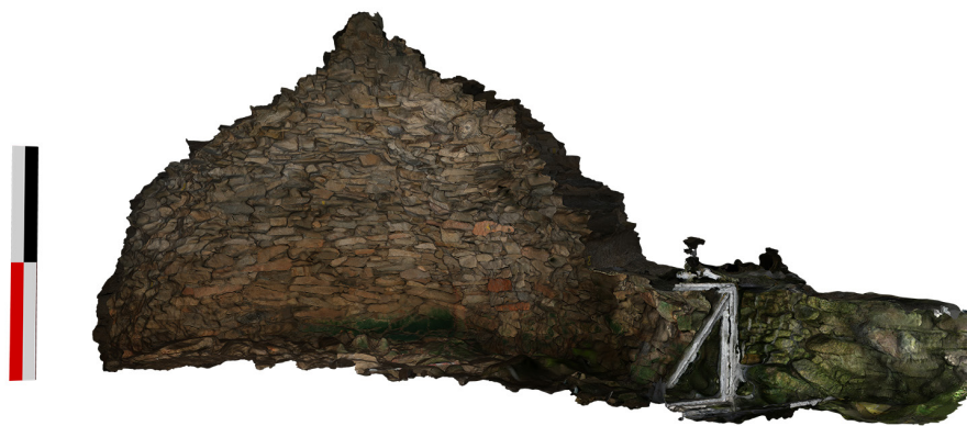
Fig. 4 : Photo en FOV 48° (œil humain) du modèle 3D de la chambre centrale de Carn réalisé par photogrammétrie. L'encorbellement présent dans cette chambre est l'un des cinq conservés depuis le Néolithique dans l'ouest de la France.
