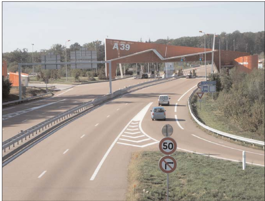
Photo. 1 - Le diffuseur de Bersaillin près de Poligny (Cliché : Pascal Bérion)
