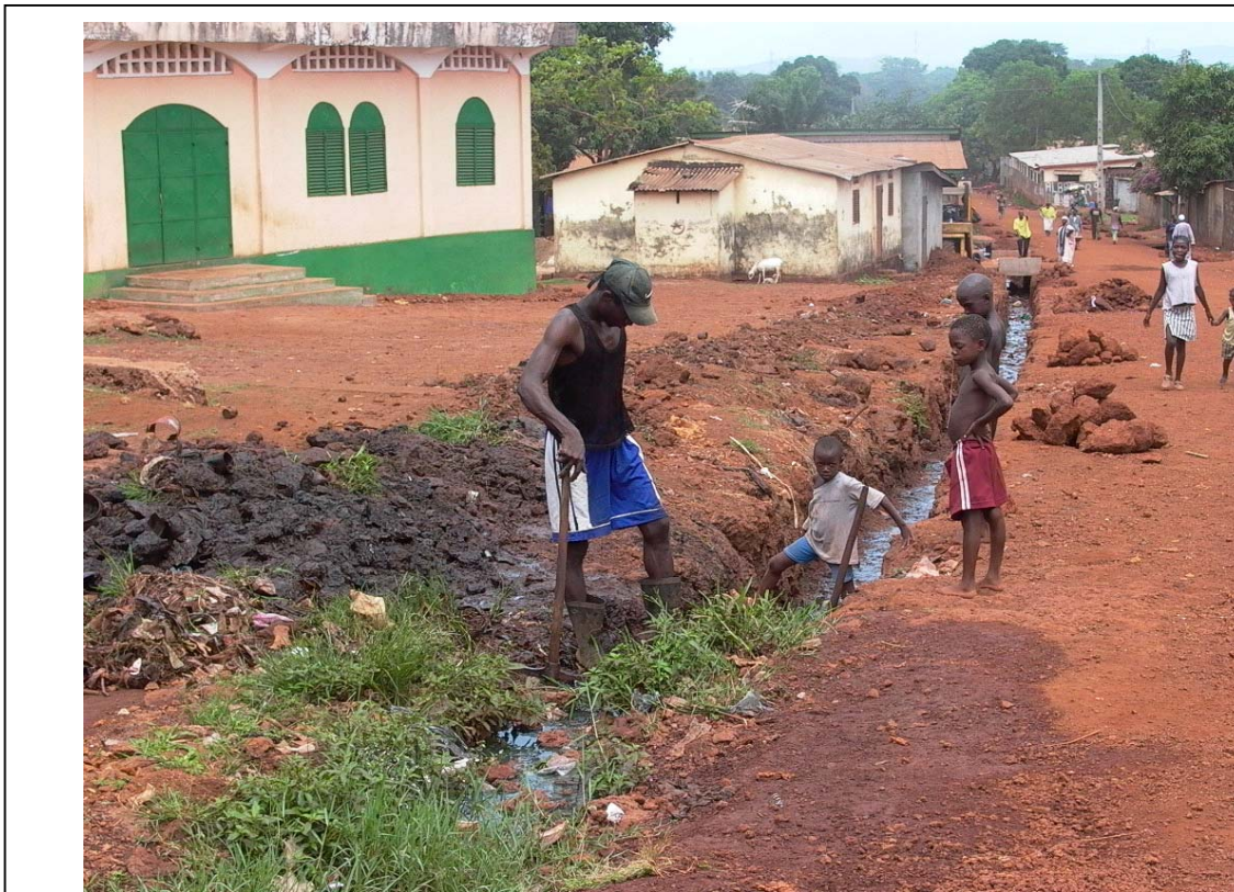
Photo 8 PDU 3 : Travaux d'assainissement dans un nouveau quartier
